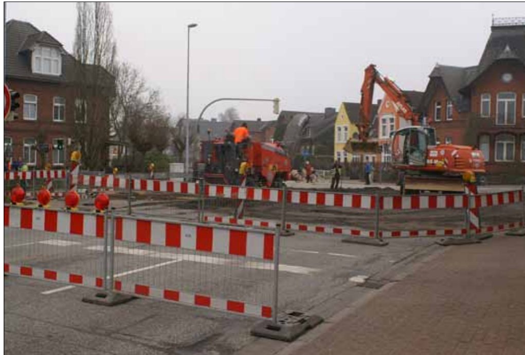
Umfangreiche Bauarbeiten an der „Spinne“.
