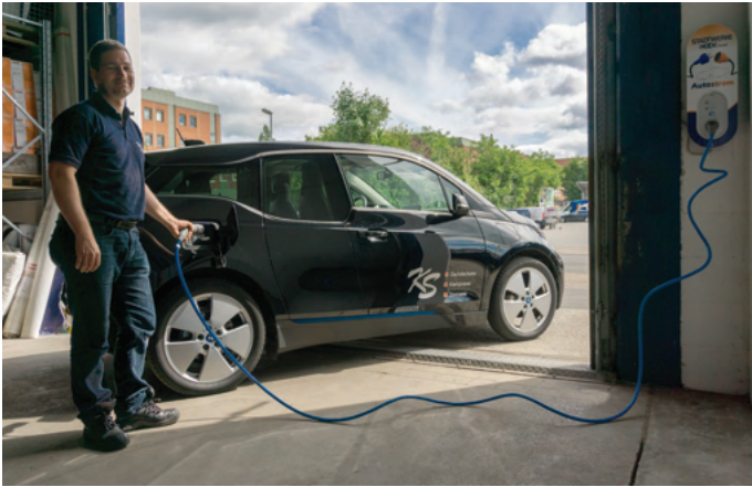
Auch Heiko Sothmann setzt mit seinem BMW i3 auf E-Mobilität. Eigens dafür hat er sich eine Wallbox installiert.
