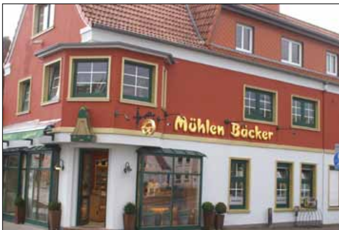
Die Fassade des Heider Ladens wurde gerade erneuert
