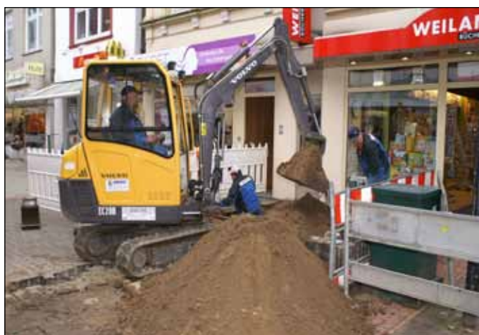
Aufwändige Arbeiten der Stadtwerke in der Friedrichstraße.
